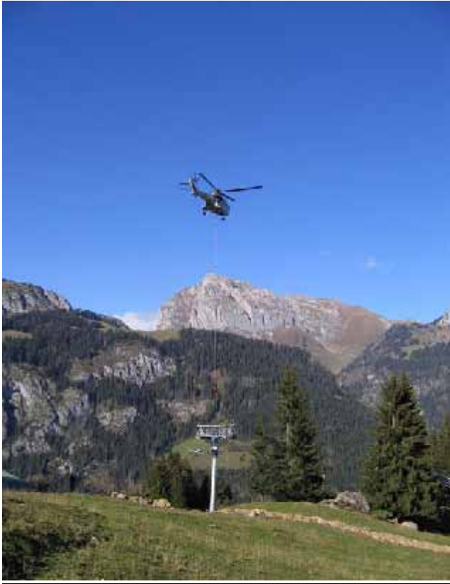
L'hélicoptère qui facilite grandement la pose et dépose des pylônes pour respecter un échancier très rigoureux (photo B Auzou)
