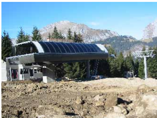
La gare d'arrivée du nouveau télésiège (photo J leconte)
